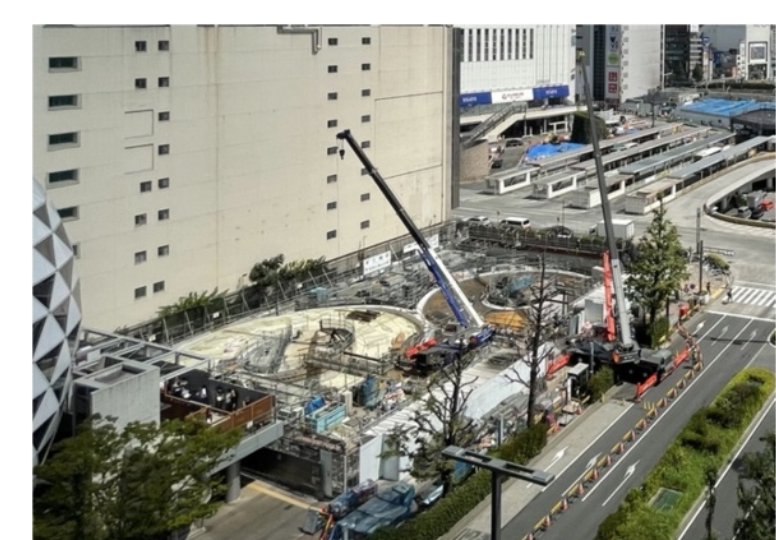
新宿駅西口地上（南西側）から スノールビル跡地（施工箇所）を臨む (撮影日：R6(2024)年9月)
