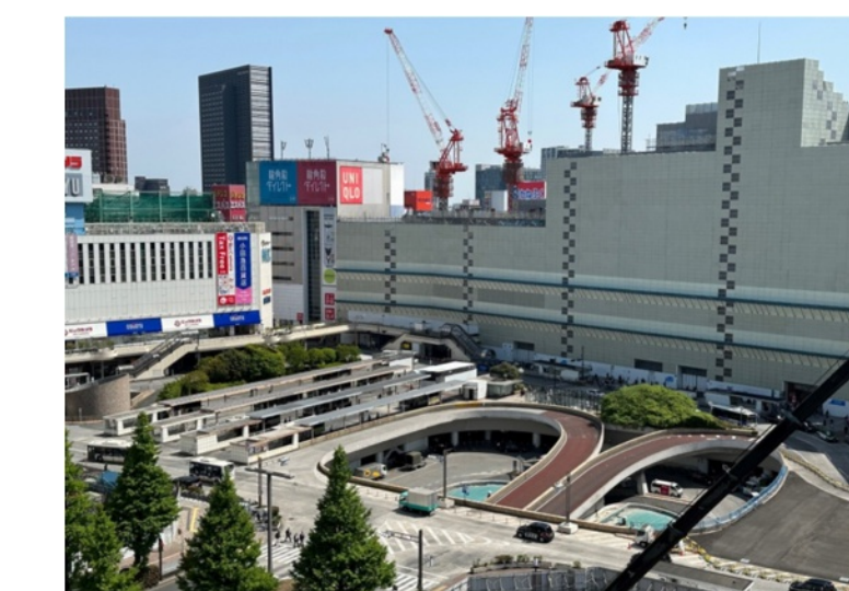
新宿駅西口地上（南西側）から スロープ車路（メガネ車路）を臨む (撮影日：R5(2023)年4月)
