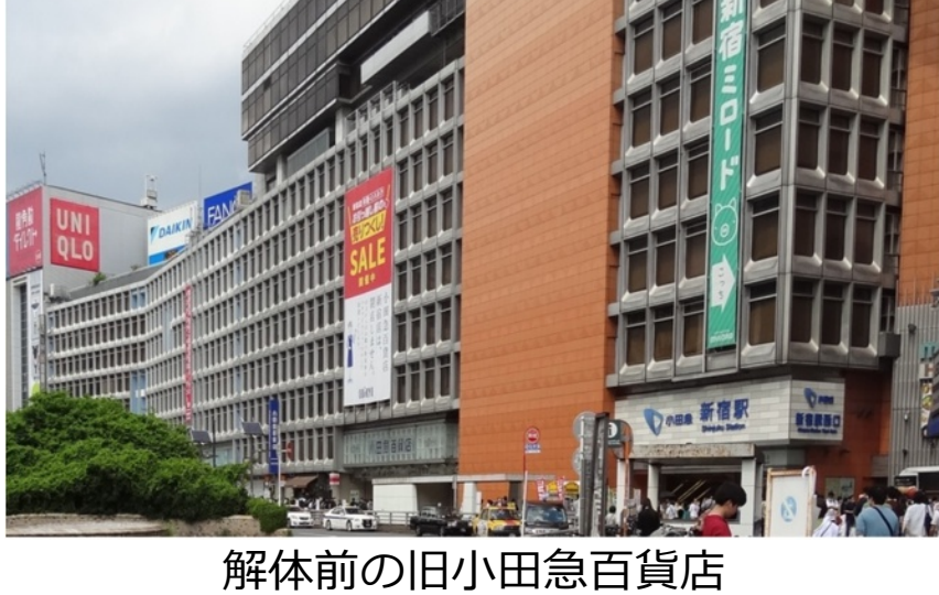
解体前の旧小田急百貨店 (撮影日：R4(2022)年5月)
